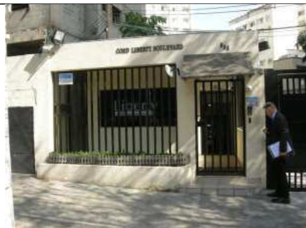
Foto 03 – Entrada principal e guarita do conjunto residencial.
